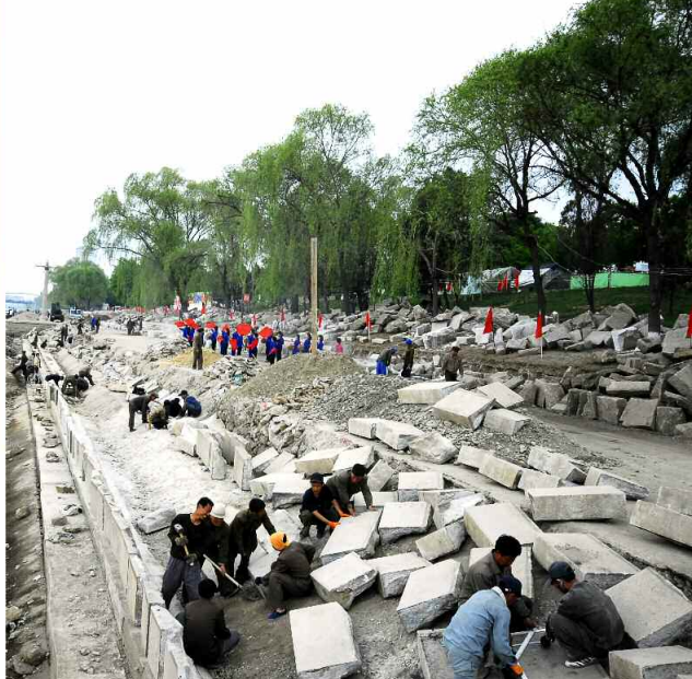
물길굴확장공사 현장 모습
