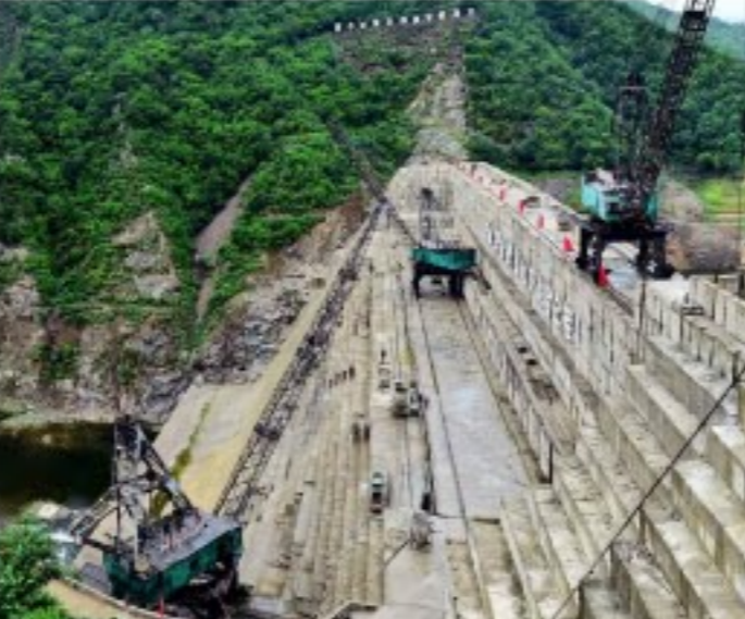
어랑천발전소 팔향언제건설 현장 모습
