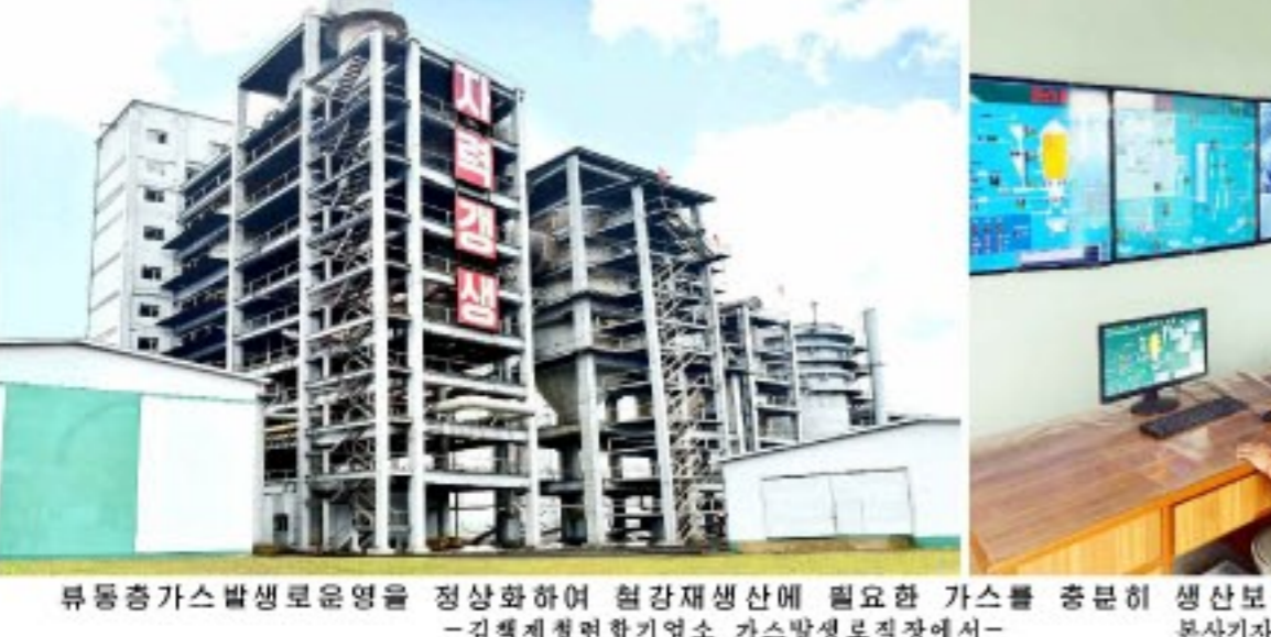
부동층 가스발생로연열을 정상화하여 열교환기에 필요한 가스를 충분히 생산보장하고 있다. -김책제철연합기업소 가스발생로직장에서-
