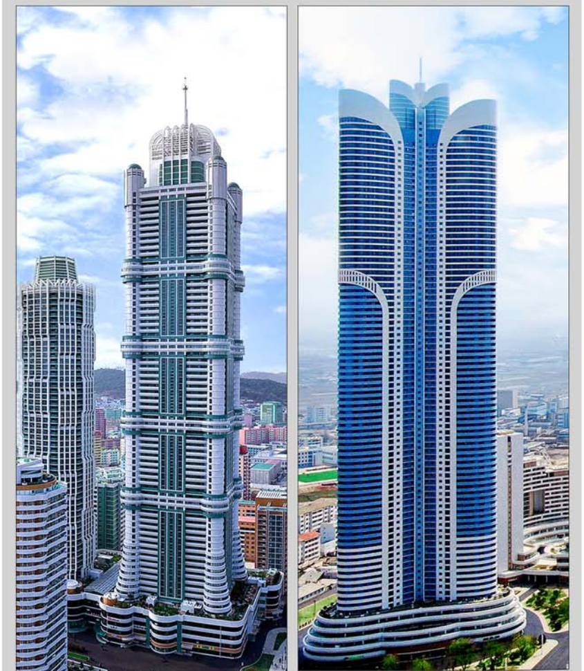
송영일은 러명거리의 70층살림집과 송화거리의 80층살림집의 내진구조에 대한 과학적인 론증으로 초고층건물들의 안정성을 담보하였다.
