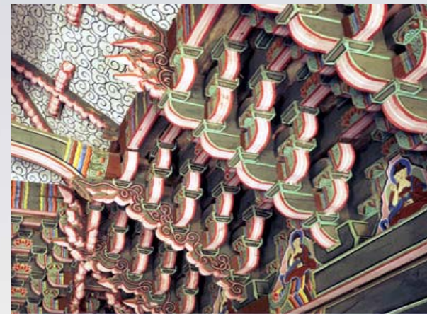
룡흥사 대웅전 내부두공장식
