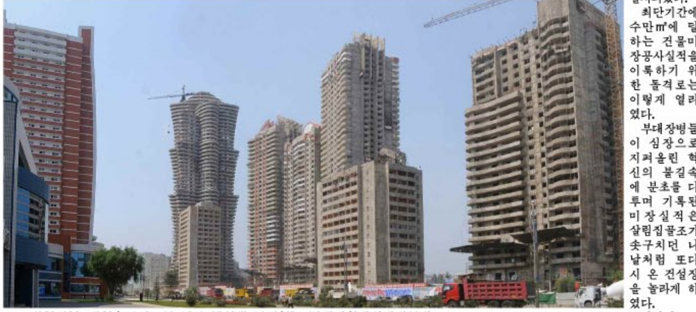
평양정신, 평양속도창조의 열풍 세차게 불아치는 미래과학자거리건설장 본사기자 림 학 락 찍음
