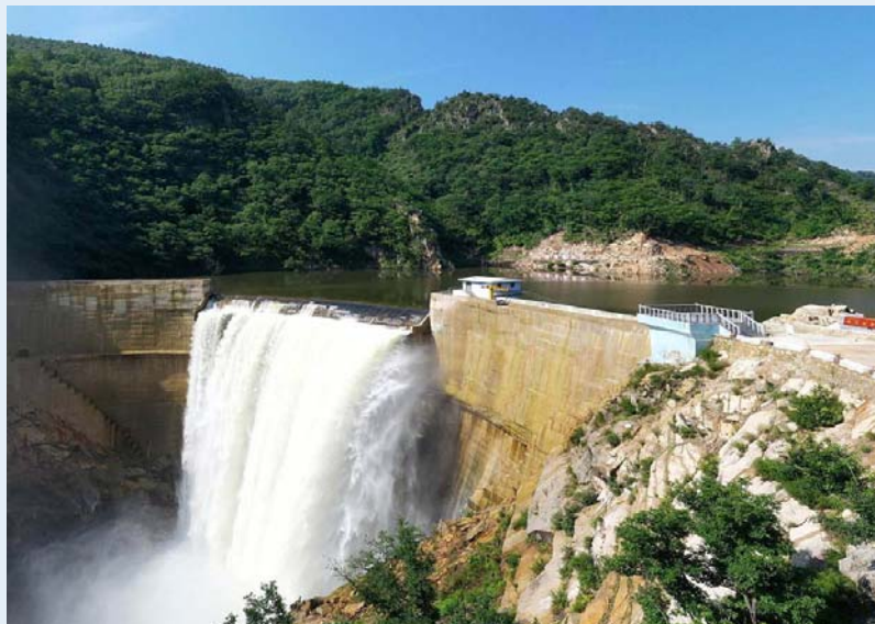
함경북도에 건설된 어랑천3호발전소연제
